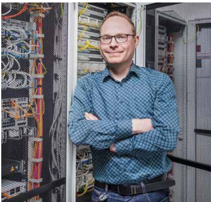
IT-Abteilungsleiter Manuel Schupp vor einem Serverschrank in der Zentrale im Leoniweg.
